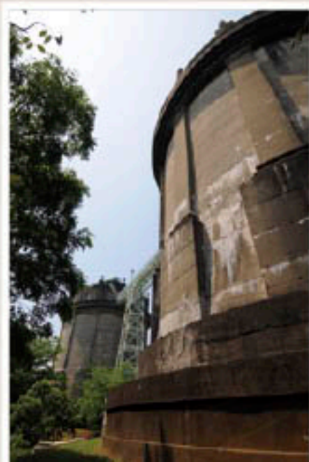
選奨土木遺産 に認定された 駒沢給水所の 配水塔。「双子 の給水塔」と して親しまれて いる
