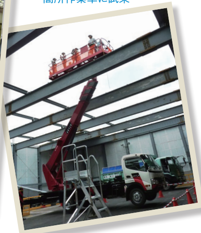
高所作業車に試乗
