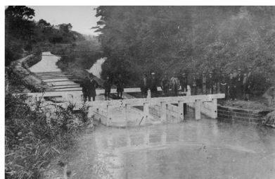
円筒分水ができる前の 久地分量樋。 明治43年4月に撮影された 竣成記念写真 （『稲毛川崎二ヶ領用水事績』より）
