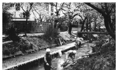
親水護岸工事 （昭和61年頃の様子）
