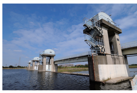
二ヶ領上河原堰堤。 昭和20年にコンクリート堰になった
