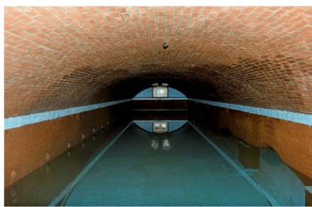
戸祭配水場配水池内部。創設期より使用している。現在は松田新田浄水場(宇都宮市)から送られた水をためている
