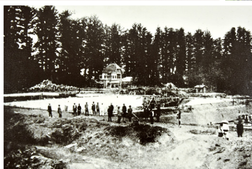
建設時の今市浄水場
