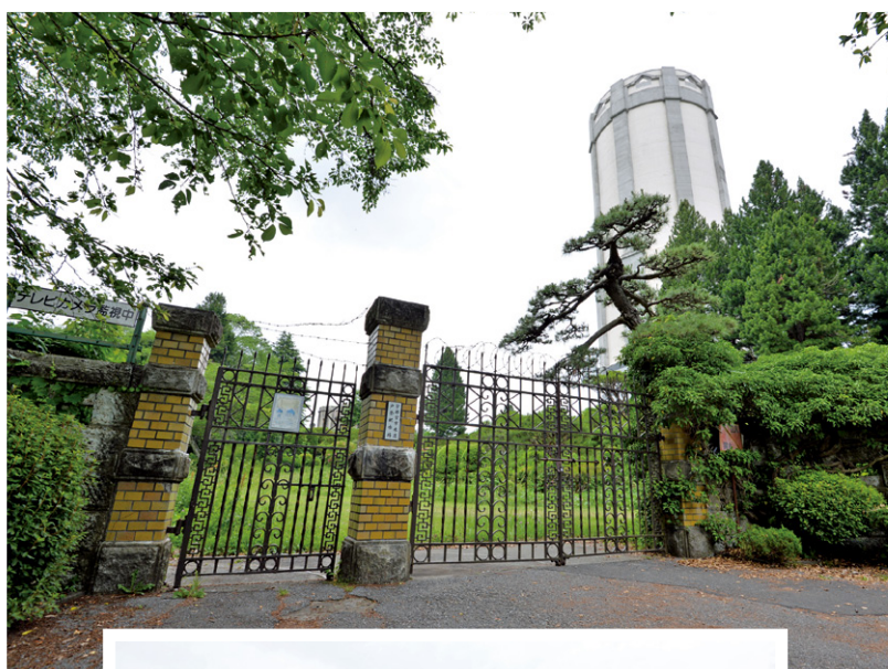
戸祭配水場旧正門
