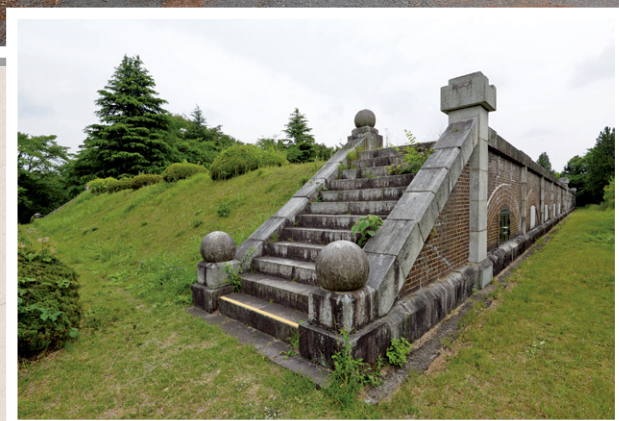
戸祭配水場内の配水池。階段は煉瓦とのコントラストを出すため御影石を使っている。壁面はフランス積みで組成され、アーチ模様のデザインが目を引く
