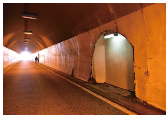
人と車が行き交う東隧道。 隧道内には避難所が5カ所ある
