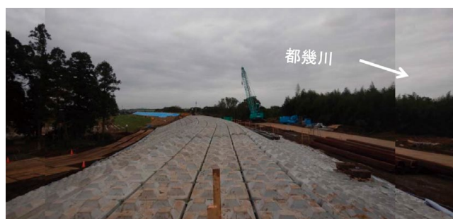
荒川水系都幾川右岸0.4k大型連結ブロック施工完了(10/24 8:00頃)
