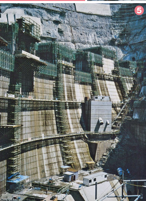
⑤ ダム本体コンクリート打設建設中の様子
