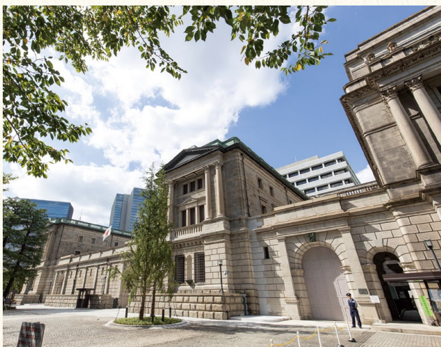
日本銀行本店本館。1896(明治29)年に完成。設計は東京駅などを手がけた辰野金吾。国の重要文化財である
