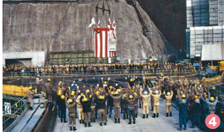
④ 本体コンクリート打設完了を祝う技術者たち
