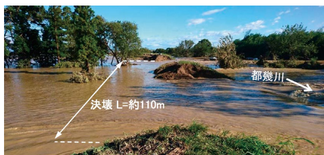
荒川水系都幾川右岸0.4k被災状況(10/13 12:00頃)
