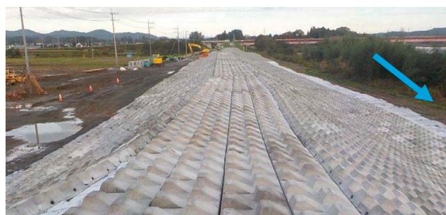
那珂川右岸28.6k接続ブロック施工中(10/28 7:00頃)
