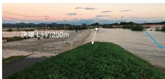
那珂川右岸28.6k被災状況(10/13 6:15頃)
