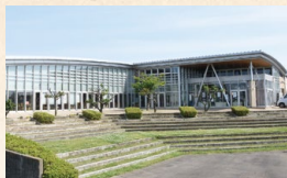
手賀沼のほとりにある道の駅「しょうなん」。約3倍の規模へと拡張工事が進んでいる
