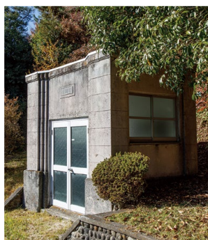
軒蛇腹が優雅な水道計量室
