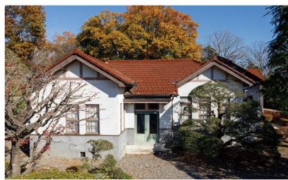
配水池の脇にある水道山記念館。 管理事務所として使用されていた
