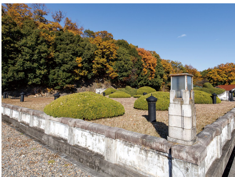
緑町配水場の配水池
