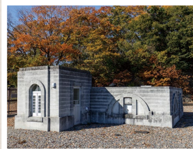
接合井。浄水場と配水場 を連結する施設
