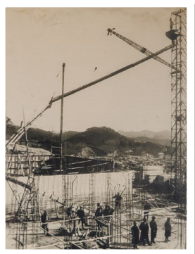
築造工事中の緑町配水場 (提供: 足利市水道局)
