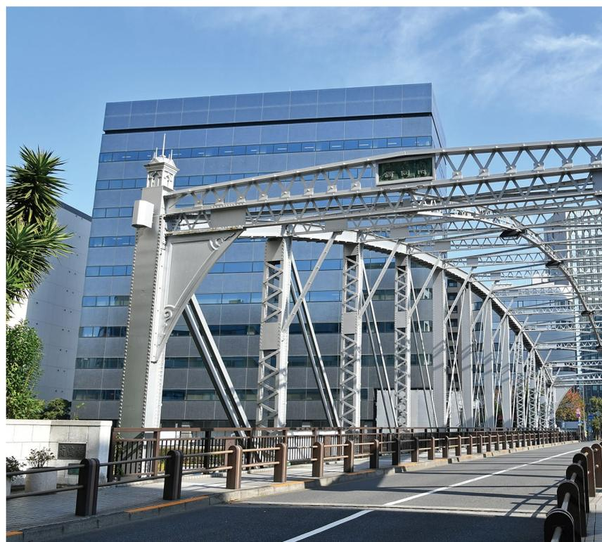
部局も廃局した後の昭和6(1931)年1月に始まります。当初の区画整理計画が途中で変更されたために、急遽決まった架設計画でした。この降って湧いたような予定外の設計変更を予算内で収めるべく、東京市が行ったのが旧両国橋の転用でした。3連あったアーチの中で一番状態の良い中央径間を補強し、幅員を狭めて移設しました。総工費は、新しく橋を架けるより2割ほど安くできました。工事は急ピッチで進められ、着工の翌年の3月3日に南高橋は竣工しました。
