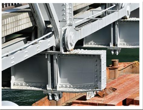
アメリカ式トラス橋の特徴であるアイバー。部材を剛接せずピンで留めているため車両の往来で微妙に動く
