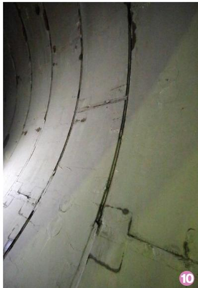
⑩⑪ ⑩はセグメントのつなぎ目が見えるトンネル壁。シールドマシン前面のカッター盤が回転して土を掘り、掘り終わったところにセグメントが自動で組み上げられる。⑪は排水機場の広場に、記念に設置されたカッター盤
