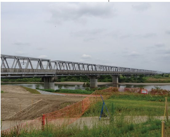
利根川に架かる東北新幹線橋梁
