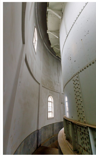
配水タンク。当時は大型プレス技術はなく、三角形のパーツをリベット接合して丸底にした
