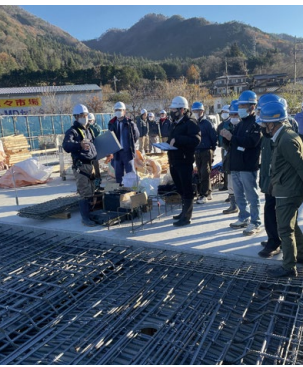
国道20号法雲寺橋上部工事 現場視察
