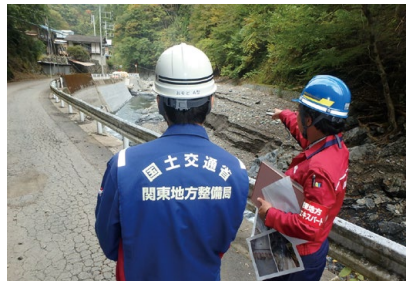
防災エキスパートによる災害対応支援活動 東日本台風豪雨被災状況調査
