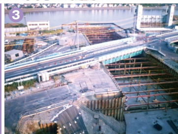
③ ④ 放水路と中川の接続部分 (③は施工時)。平常時は右側 (④画面中央) の八潮水門から自然に排水し、綾瀬川増水時には排水機場で汲み上げた水を左側の吐出樋管ゲートから排出する (③写真提供：江戸川河川事務所)
