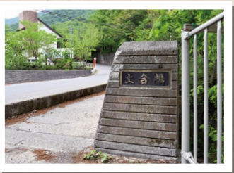
下流側にある土合橋。 ここから堰堤を一望できる
