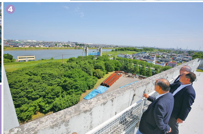
③ ④ 放水路と中川の接続部分 (③は施工時)。平常時は右側 (④画面中央) の八潮水門から自然に排水し、綾瀬川増水時には排水機場で汲み上げた水を左側の吐出樋管ゲートから排出する (③写真提供：江戸川河川事務所)
