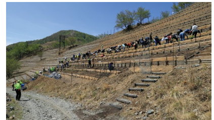
体験植樹及び植樹地の整備(日光市足尾町)
