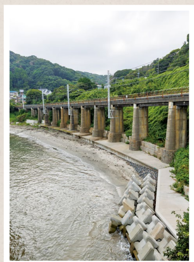
海岸線に沿って建つ山生橋梁。 台風の際は海水が橋脚にまで及ぶ
