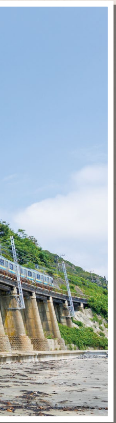
主桁の断面をT型にすることで、長径間の鉄筋コンクリート桁を実現している
