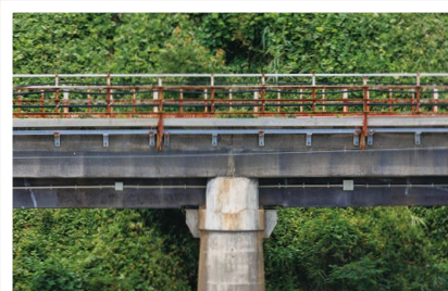
沓が取り付けられている支承部の突起。風雨を避け、景観への効果も
