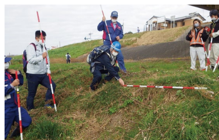
利根川上流河川事務所管内堤防点検の様子
