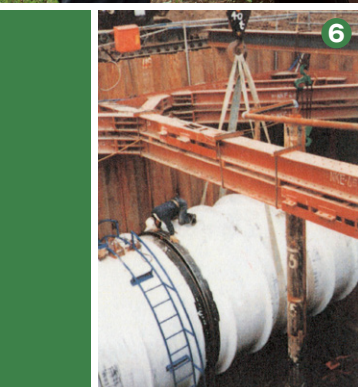
⑥⑦ 管体の接合は現場で。長年の使用に耐えるよう慎重な作業が要求された（『北千葉導水路事業工事誌』より）
