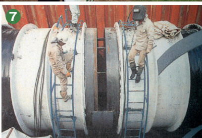
⑥⑦ 管体の接合は現場で。長年の使用に耐えるよう慎重な作業が要求された（『北千葉導水路事業工事誌』より）
