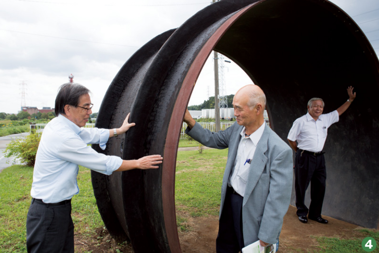
④ 埋設された鋼管は直径3.2m、強度を高めるために外側につけられたリブをあわせると3.5m。これが2本並べて埋められている
