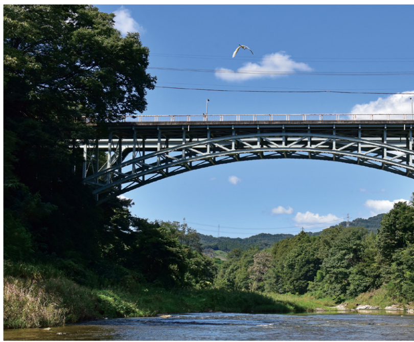
鍋川下流から見た只川橋。 右手の先に上信電鉄の南蛇井駅がある
