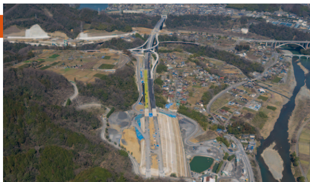
相模原IC付近 (写真提供: 関東地方整備局)
