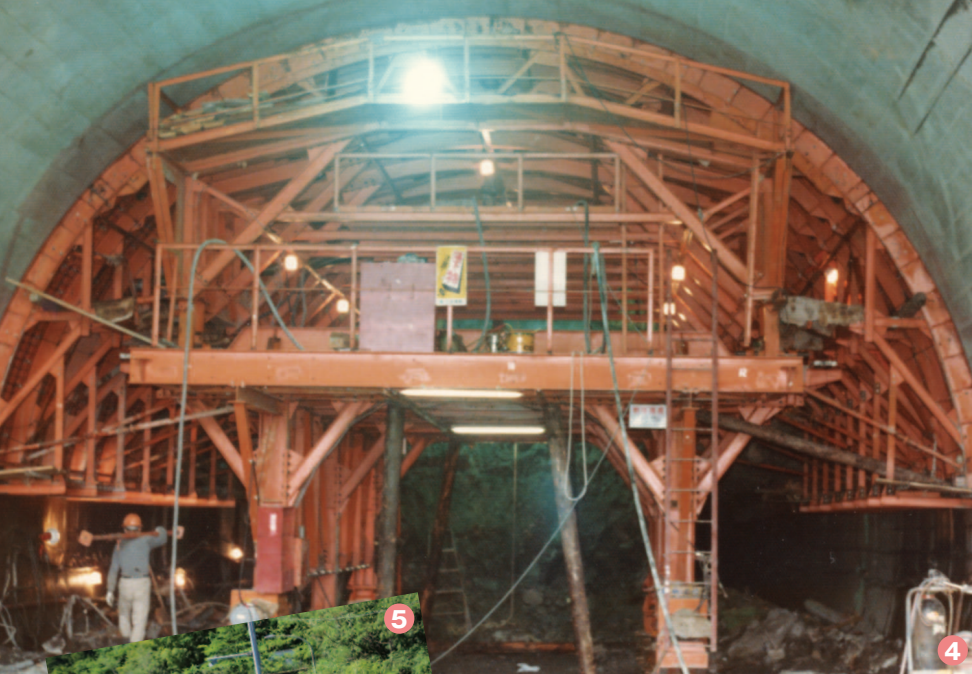
④ 南部トンネル内部の工事。坑口では地質が軟らかくて苦労したが、内部は岩質。順調に掘り進んだ
