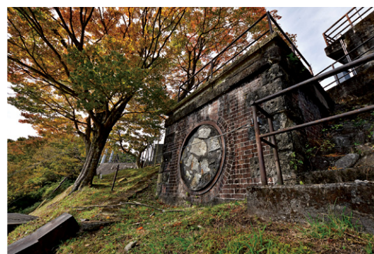
旧水圧鉄管固定台跡。 昭和22(1947)年まで使用されていた
