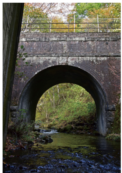
イギリス積煉瓦で組積された 木戸ヶ沢水路橋
