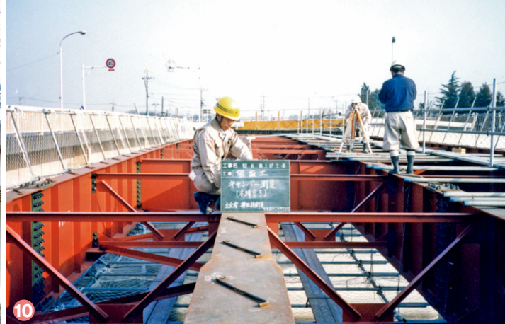
⑩ 観音橋施工中の様子
