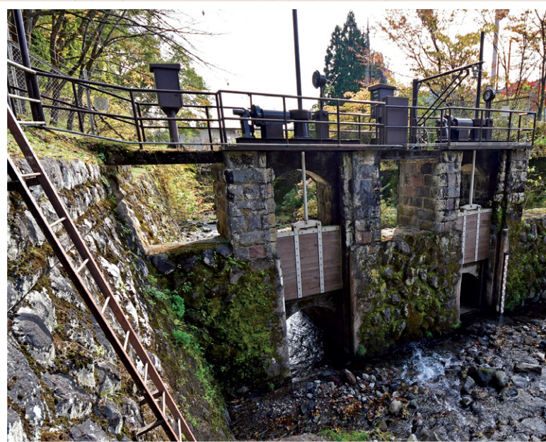
左右に広がる練積コンクリート堰堤と排砂門
