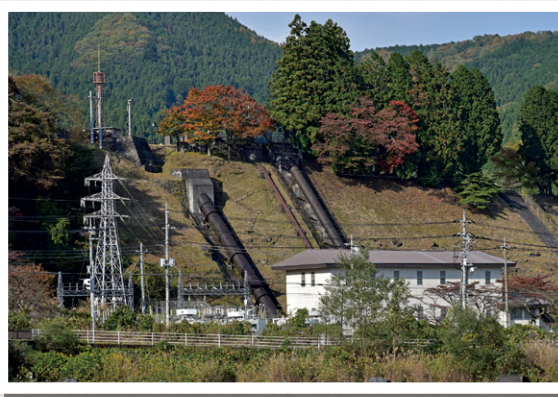
所野第一発電所。中央の色づいた木の下に 旧水圧鉄管固定台跡が見える
