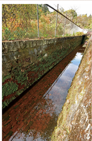
取水口から水路橋まで続く水路。側面と底には当時の煉瓦がそのまま使われている
