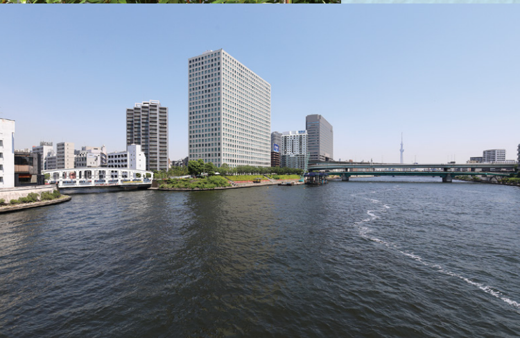
隅田川(右)に注ぐ 日本橋川(左・豊海橋)
