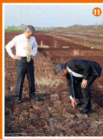
11 12 越流堤はかごマット(鉄線でできたかごに石を詰めたもの)で施工。「経済的で、補修も簡単なのでこの方法で設計・施工され、30年経ってもきれいですね」(田上さん)
