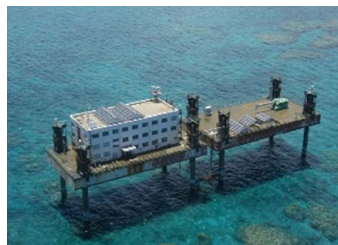
旧観測拠点施設(撤去前)
