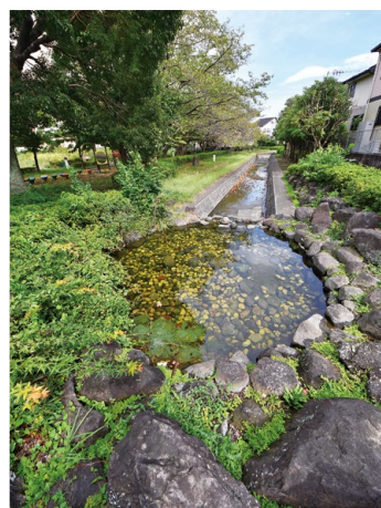
千貫樋水郷公園。水路は千貫樋を経て鴨川に続いている
