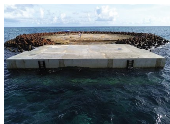
船着き場の復旧工事が完了した 観測所基盤
