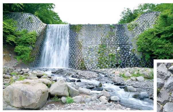
大正12(1923)年竣工の稲荷川第10砂防堰堤。昭和14~16年に嵩上げ工事を行った下流側は、丁寧に整形された間知石がかみ合い、目地はほとんど見えない
