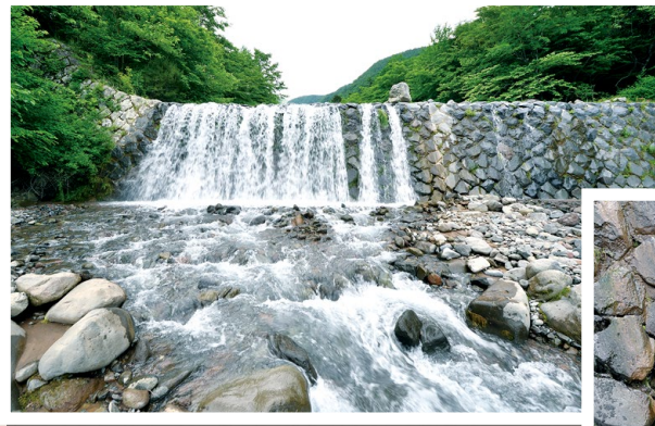
大正10(1921)年竣工の稲荷川第3砂防堰堤。第2堰堤の上流側84m地点に位置。築石は整形されているが、粗雑な点も残る
