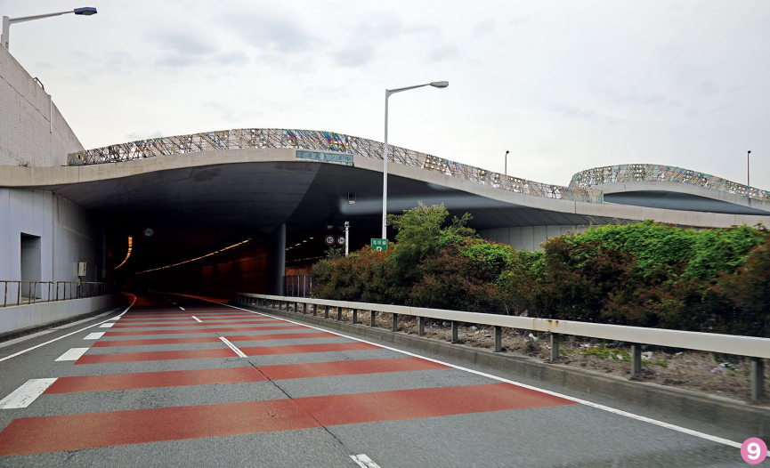
⑨ 第1トンネル坑口のデザインは現場視察時に山川朝生所長（当時、第8代）に和田さんが直訴。緩やかなカーブを描く天井と装飾的なフェンスのデザインが優雅
