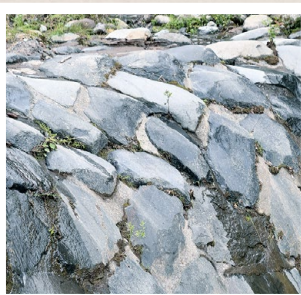
稲荷川第2砂防堰堤 (中央部拡大)。形状 が不定形な野面石 や雑割石を雑然と積 み上げた乱積
