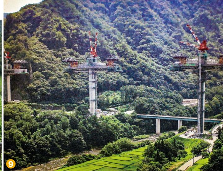
**8** **9** ダム湖に架かる不動大橋は珍しい鋼コンクリート合成桁のエクストロードード橋を採用。平成21年にダム建設が一時中止となった際は橋脚ができたばかり(9)。生活再建として必要であり放置は危険なため、この工事は続行することになった
