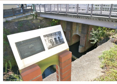
樋門の傍らにある 選奨土木遺産顕彰碑
