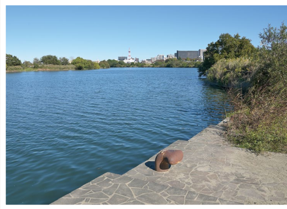
小山樋門は柳原水閘（右上）と共に江戸川からの逆流を防いだ
