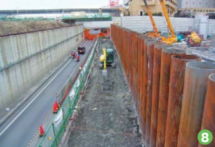
⑧⑨小台一丁目第Ⅰ期の堤防内道路部。⑧は施工中の様子 (提供: 荒川下流河川事務所)
