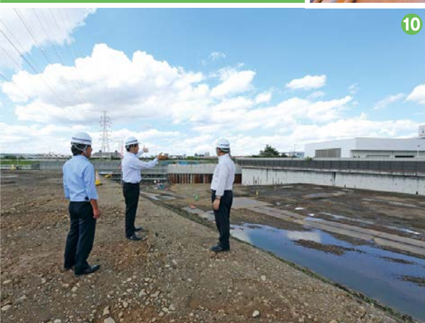
⑩小台一丁目地区は第Ⅱ期の 工事が進む(正面のコンク リートまでが第Ⅰ期施工箇所)
