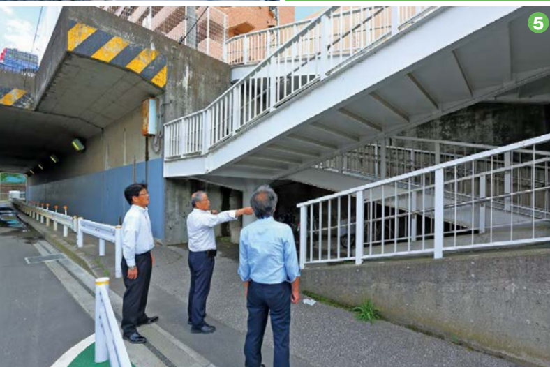
⑤この階段の幅で、隅田川側に切り回して迂回路を付けて施工することになった
