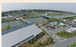
国道16号に面し、新川を挟んだ2つの建物で構成される「道の駅やちよ」
