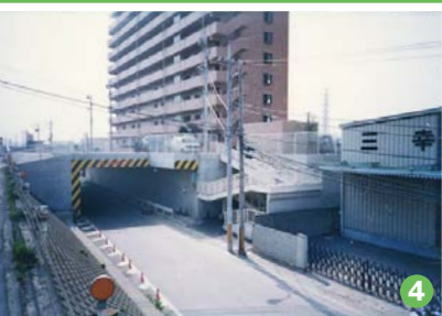
④小台地区完成当時の様子。写真左手が荒川の堤防。マンションのすぐ裏手が隅田川だ（提供：荒川下流河川事務所）
