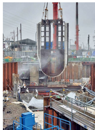
工事の山場 「マンホール角落し設置」
