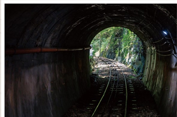
ダイナマイト掘削により貫かれ、カーブする長峰隧道
