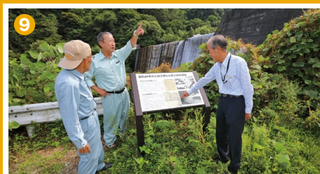
⑨災害当時を知らせる銘板。まず大武川砂防堰堤ができ、その後に、上流に砂防堰堤を造っていった
