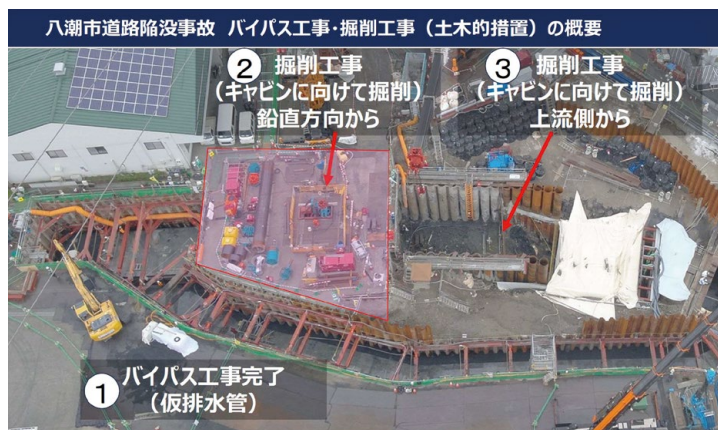
土木的措置全景 上空から
