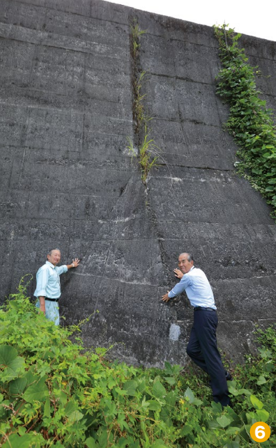
⑥大武川砂防堰堤は本体と袖部で断面が異なる「逆断面」構造。強度と経済効率のバランスをとった形。「当時この発想があったのはすごいことです」と渡邊さん
