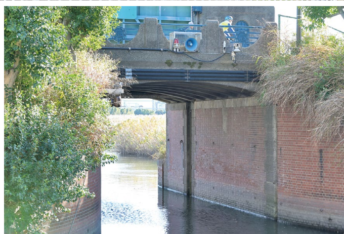
水門開口部、シャイベ式の桁と煉瓦造がうかがえる
