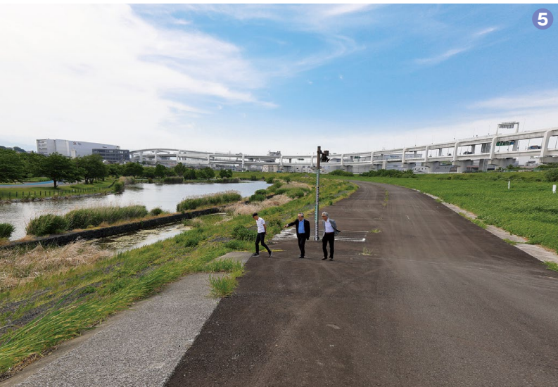
⑤遊水地上流側にある全長450mの越流堤。画面の左側が遊水地内の新横浜公園、右側の草むらの向こうに鶴見川が流れる
