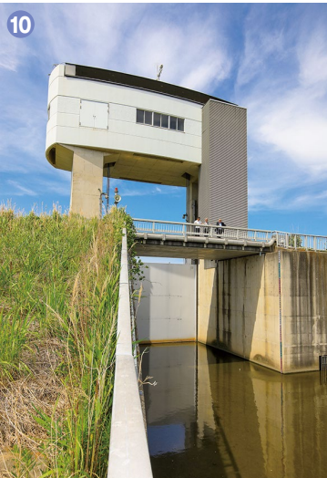
⑩ 遊水地内に流れ込んだ水は、河川水位が下がった後、この排水門から少しずつ鶴見川に排水される
