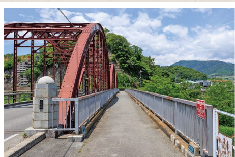
後年になって 架橋された歩道
