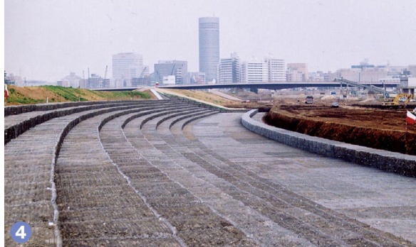
⑤遊水地上流側にある全長450mの越流堤。画面の左側が遊水地内の新横浜公園、右側の草むらの向こうに鶴見川が流れる
