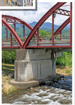
歩道設置時に 耐震化のため 巻き立てられた 橋脚部分
